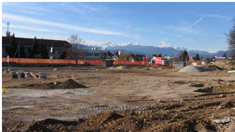
Športni park Radovljica: osnovni izkop
