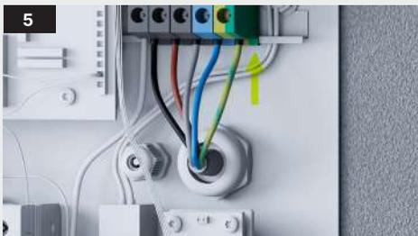
**SI** Olupite kabel in na dovodne sponke privijte dovodni kabel. Za dovod je pripravljenih 5 sponk (tri F, in po en NE in PE).
