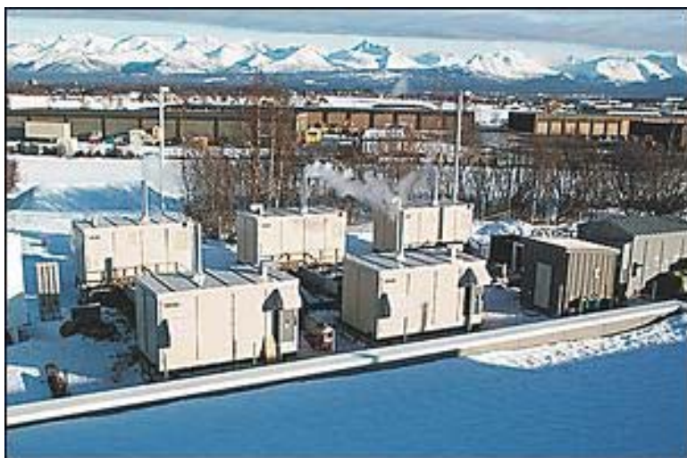
Slika 16. Instalacija petih PC 25TM gorivnih celic v Anchorage-u na Aljaski za zagotavljanje električne energije in toplote v mestu
